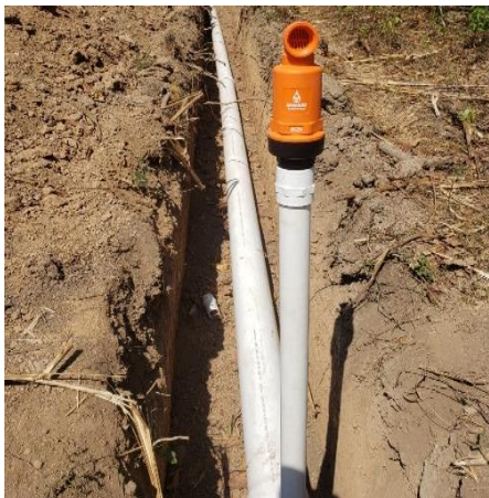
Figura 4.18 Válvula de aire en tubería de PVC.
