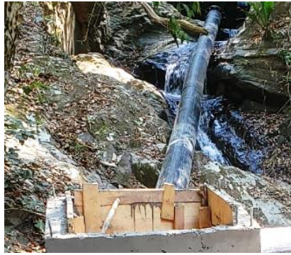
Figura 4.10 Tubo colector en obra de toma.
