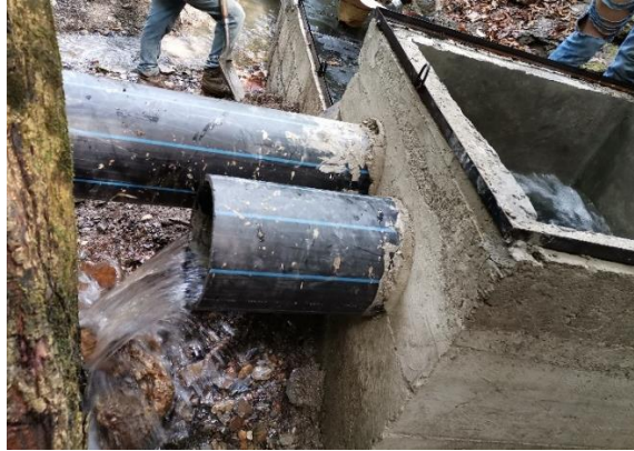
Figura 4.15 Tubo de masías en obra.
