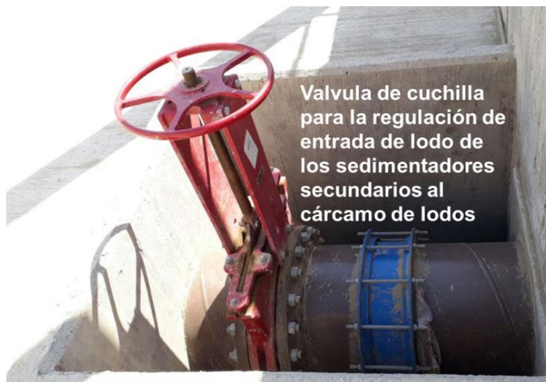
Fig. 51 Válvula de cuchilla.
