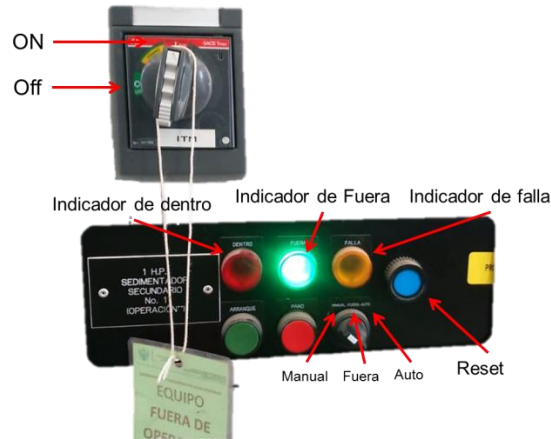
Fig. 25 Ejemplo de botonera en el CCM para rastras.
