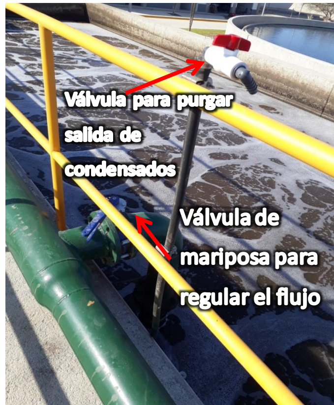
Fig. 40 Válvulas de purga y de flujo.
