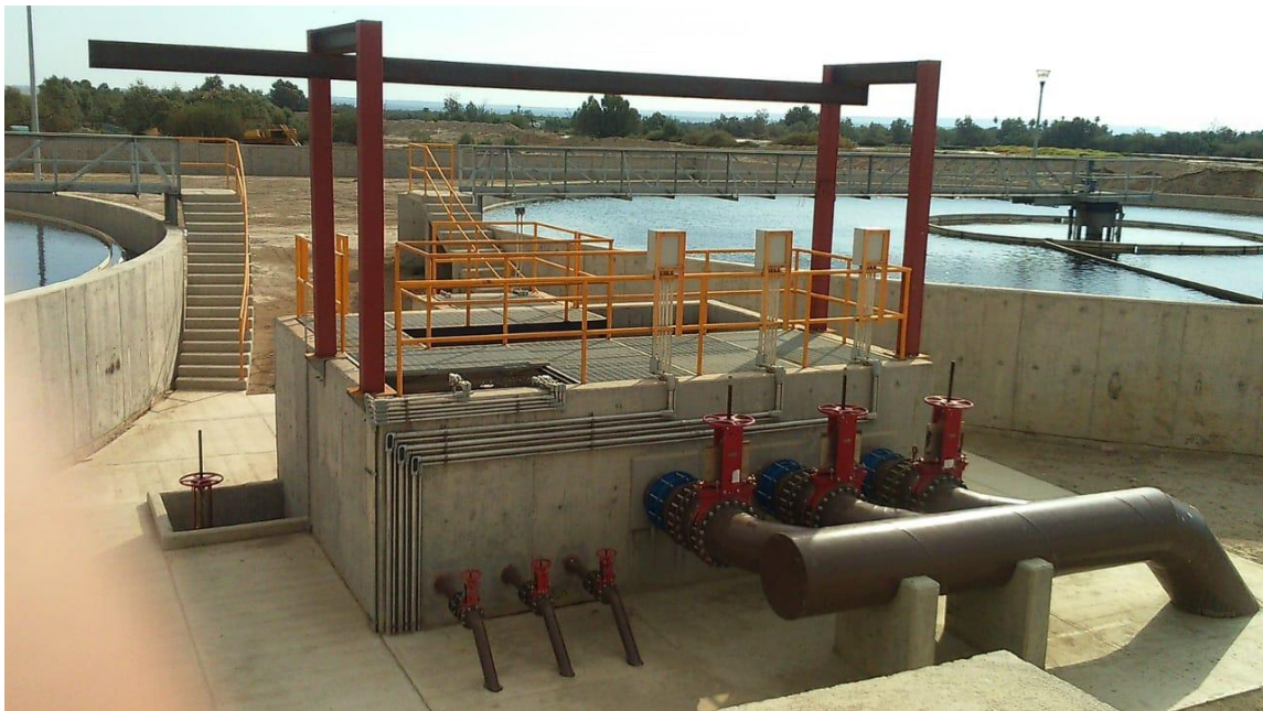
Fig. 49 Cárcamo de lodos secundarios
