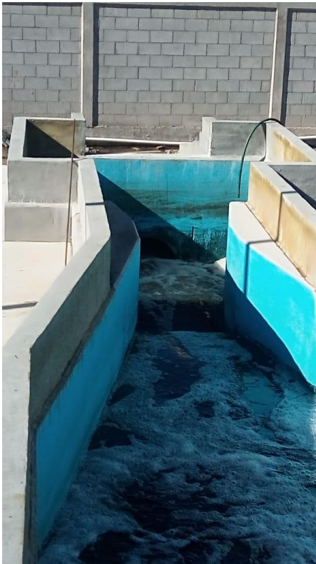
Fig. 66 canal Parshall.
