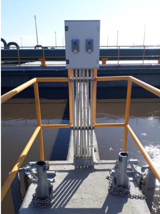
Fig. 34 Botonera local de mezclador.
