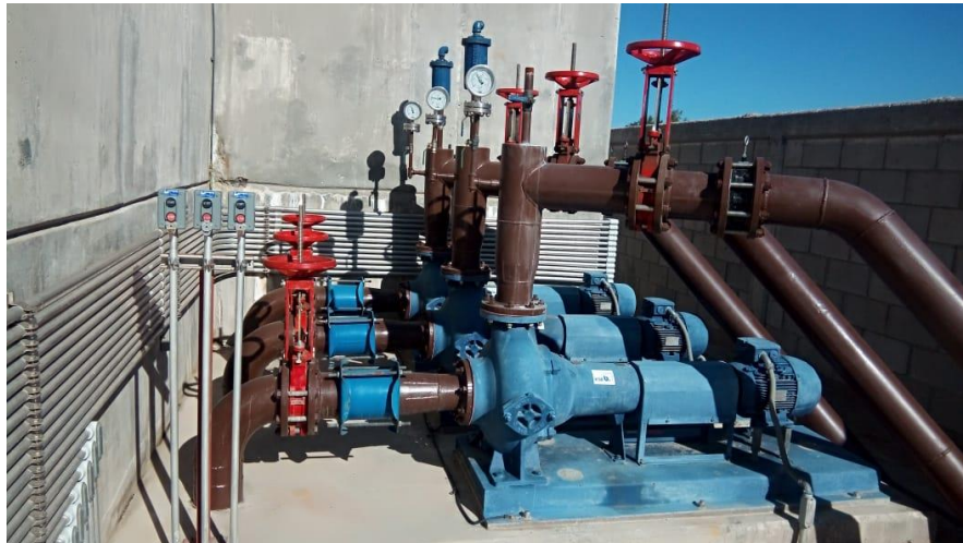
Fig. 39 Botonera local de las bombas de inyección de agua cruda.
