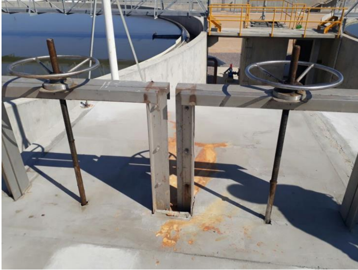
Fig. 24 Caja derivadora en la entrada al tratamiento primario.
