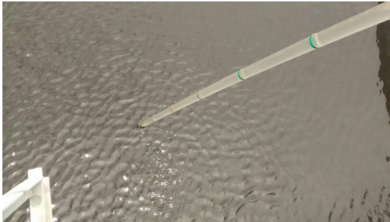
Fig. 48 Ejemplo de prueba de colchón de lodos.
