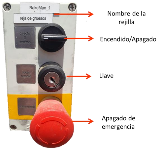
Fig. 9 Funciones de la botonera local.
