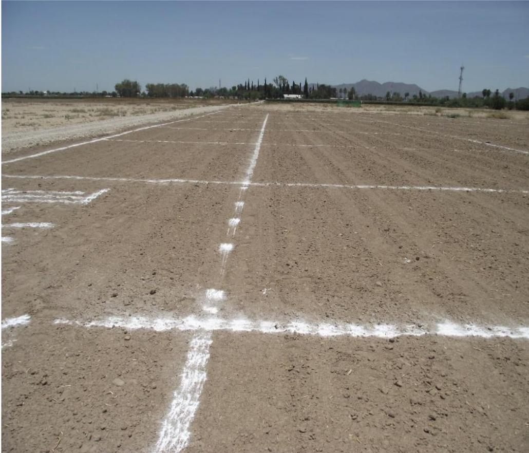
**Figura 15.** Trazado de bordos horizontales y bordo para el tubo principal del riego por multicompuertas.
