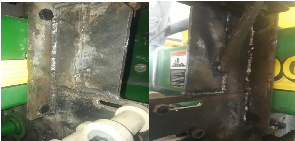
Figura 5.8 Soporte y placas soldadas.
