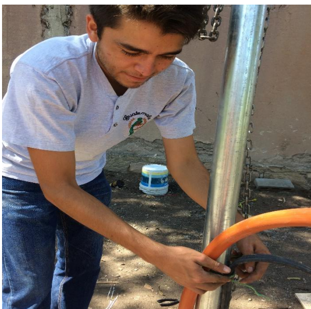
Figura 35. Colocación de la bomba sumergible para el pozo
