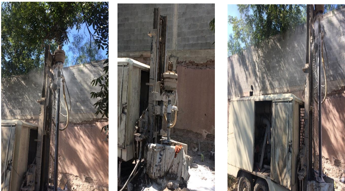
Figura 29. Máquina utilizada para la perforación y sus elementos
