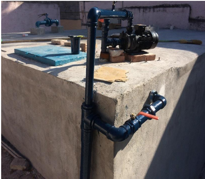
Figura 38. Colocación de la Bomba Centrífuga para Re-bombeo.
