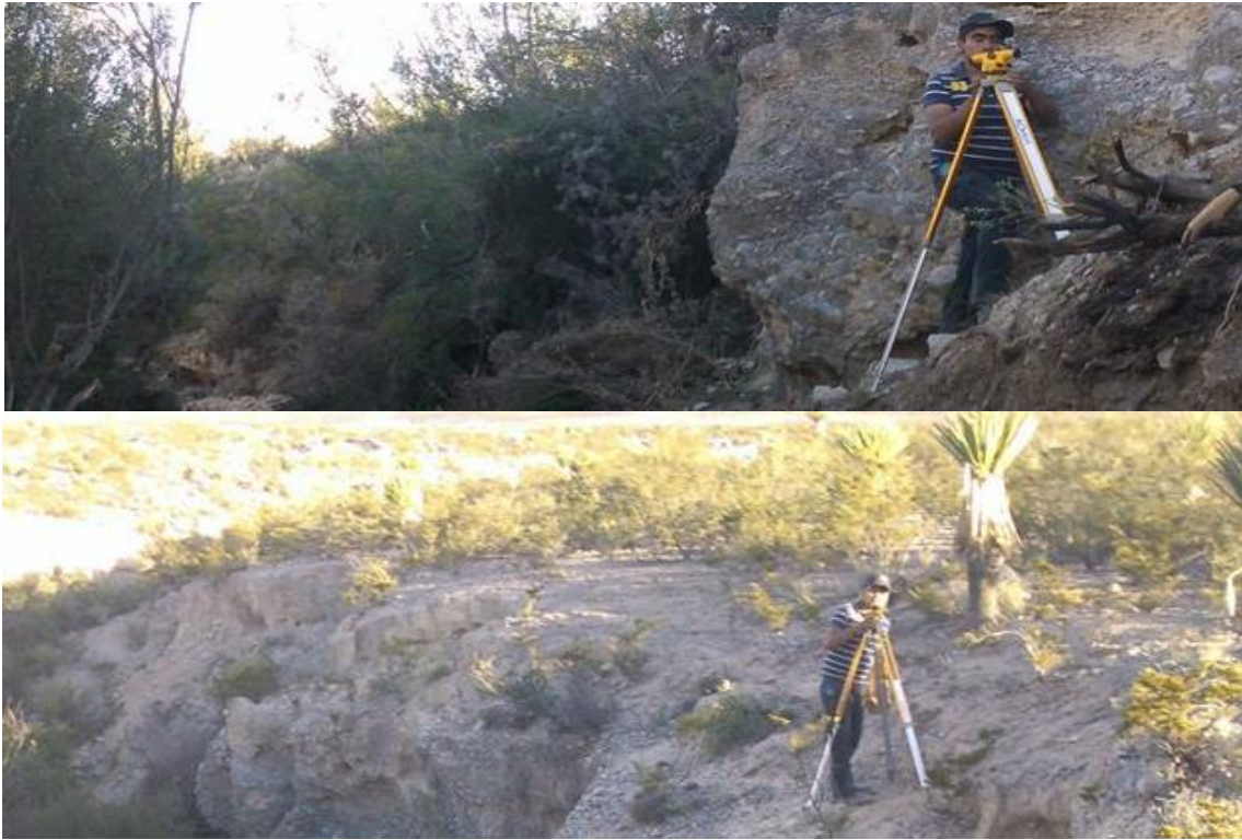
Figura 22. Levantamiento topográfico del cauce de la cárcava y unión de las presas a un banco de nivel.
