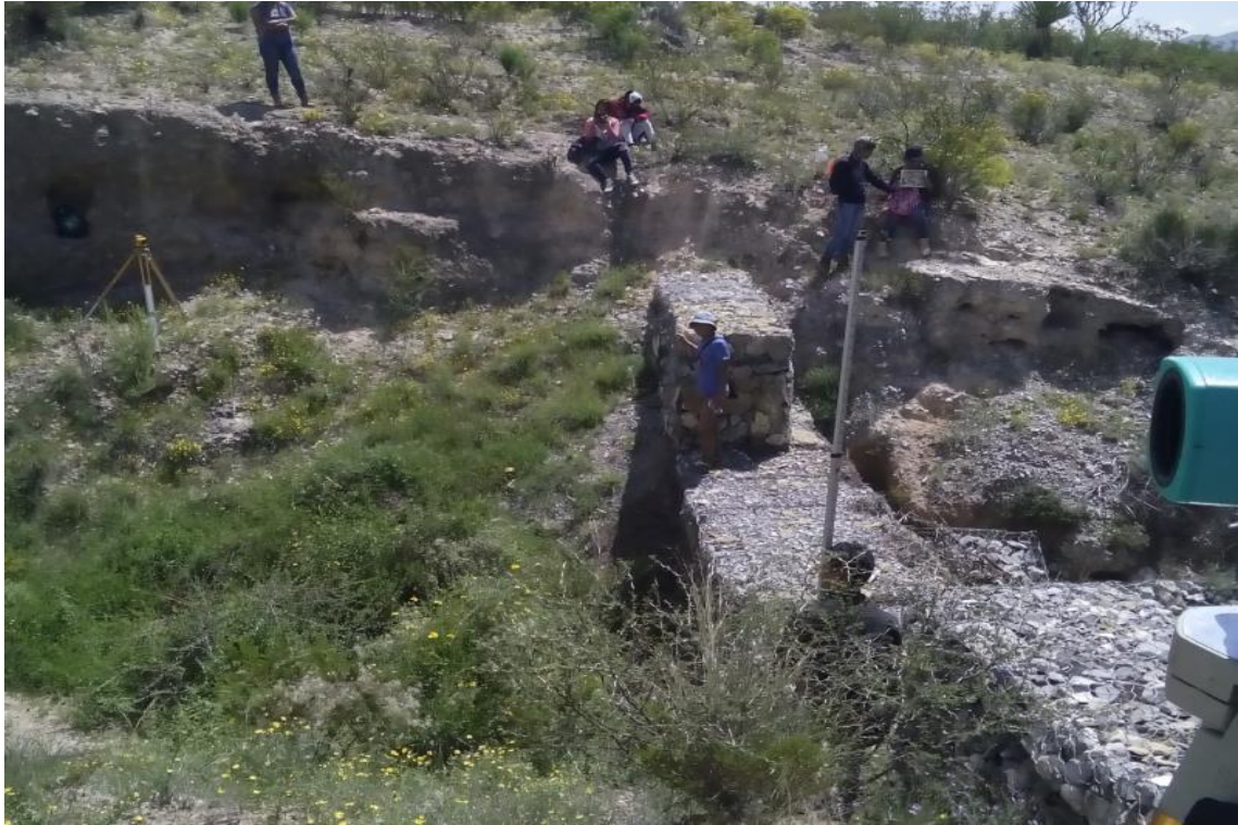
Figura 23. Levantamiento topográfico actual (presa 10), el cual muestra el azolve acumulado.
