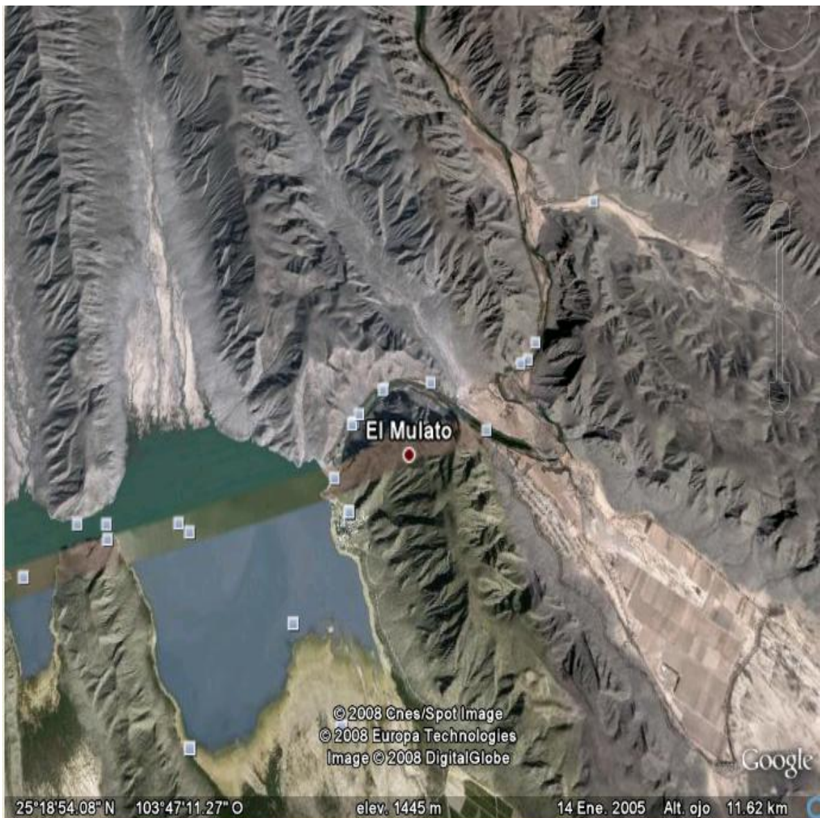
Fig.1 Presa Francisco zarco vista norte
