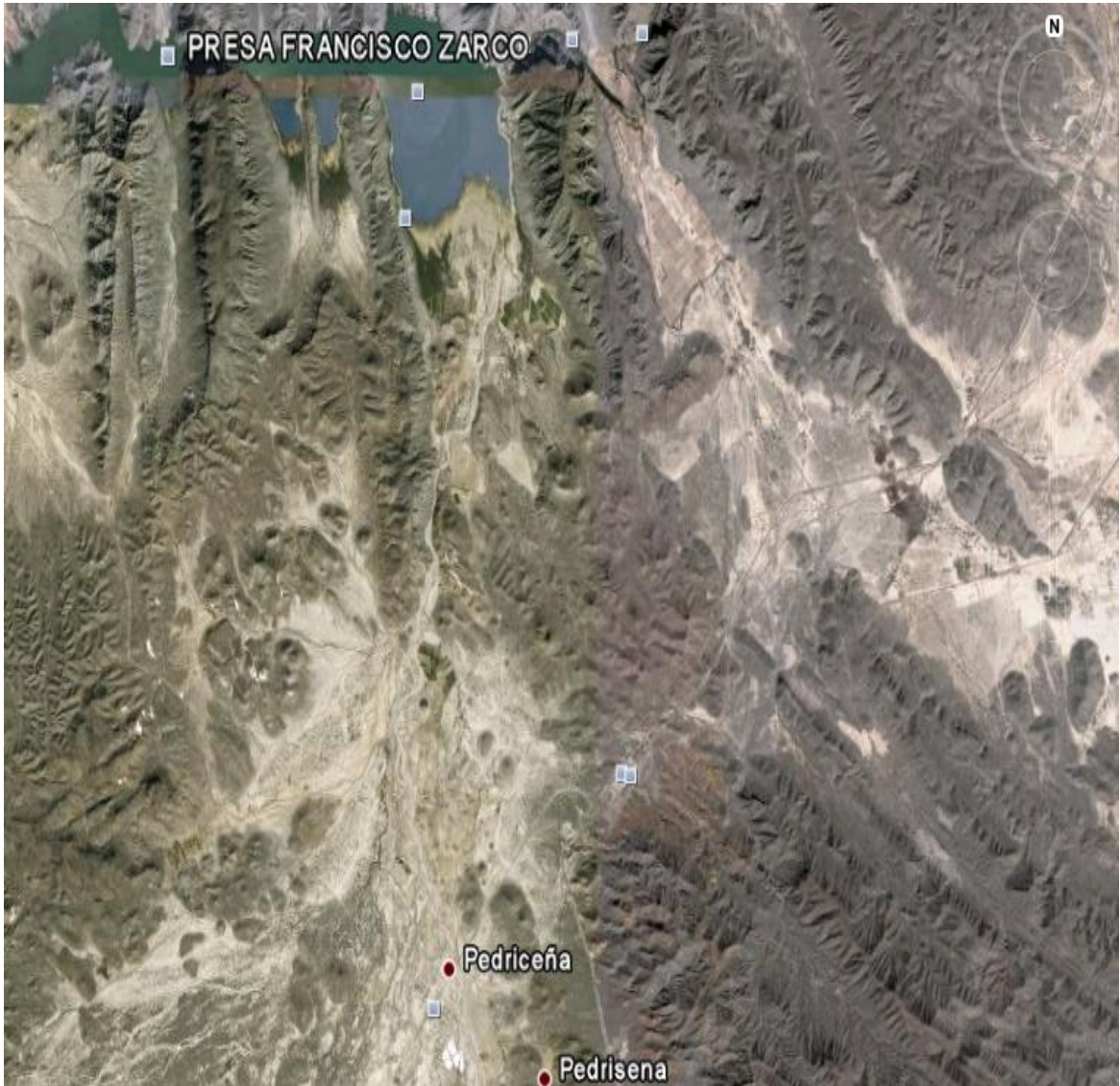
Fig.2 Presa Francisco Zarco entrada por Pedriceña
