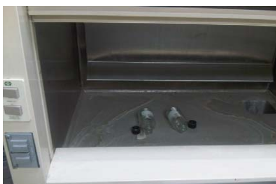
Figura 10. Campana de extracción de gases UAAAN-UL.
