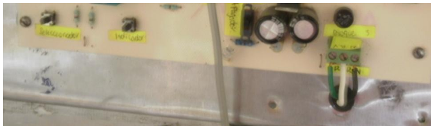
Figura 3.9 Conexión de los cables.
