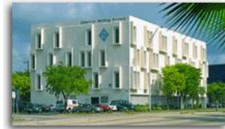
Fig.81 Edificio AWS Florida, Miami, EUA. Edificio corporativo.
