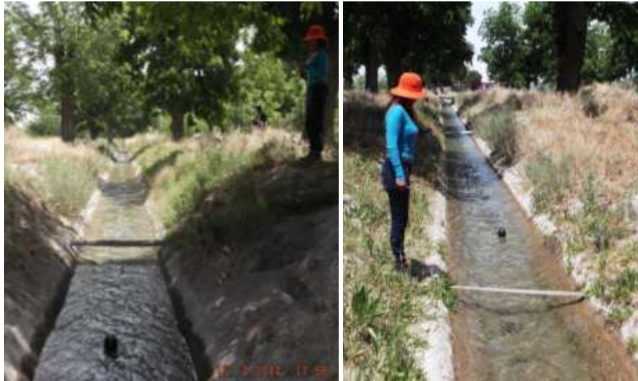
Figura 4.4 Canal del vertedero del Ejido Parras 2.
