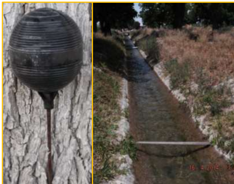
Figura 4.3 Canal del vertedero del Ejido Parras 2.
