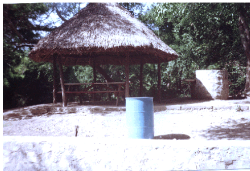
Foto 22.- Instalaciones de La Florida.
