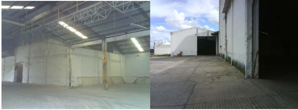
Figura 2.1 Condiciones adecuadas de limpieza internas y externas en un almacén de Penjamo, Gto.
