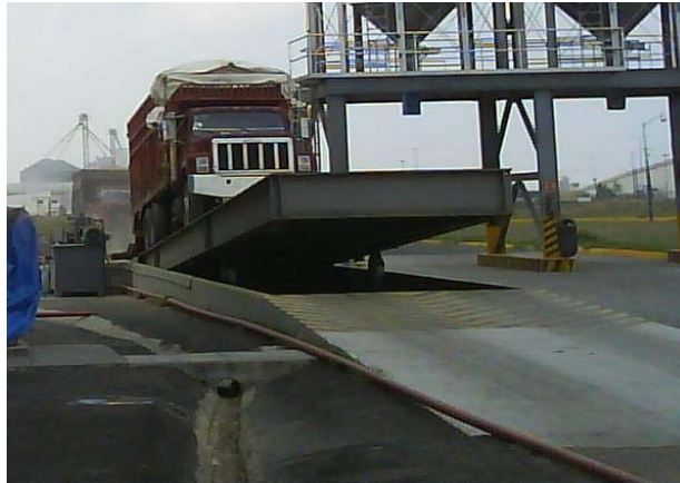
Figura 2.3 Supervisión de limpieza de la rampa en la superficie y en el interior en la Barca, Jalisco
