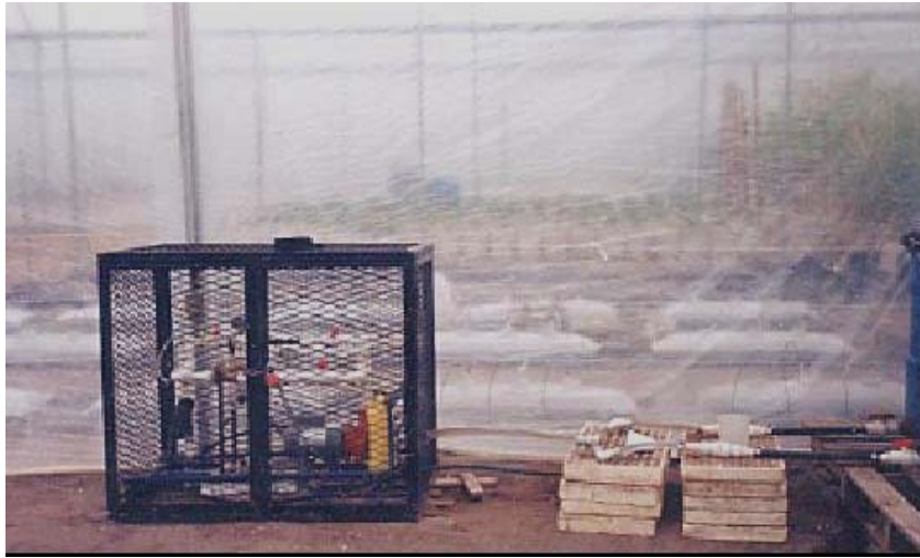
Figura 15. Equipo de bombeo para el sistema de riego en cultivo sin suelo
