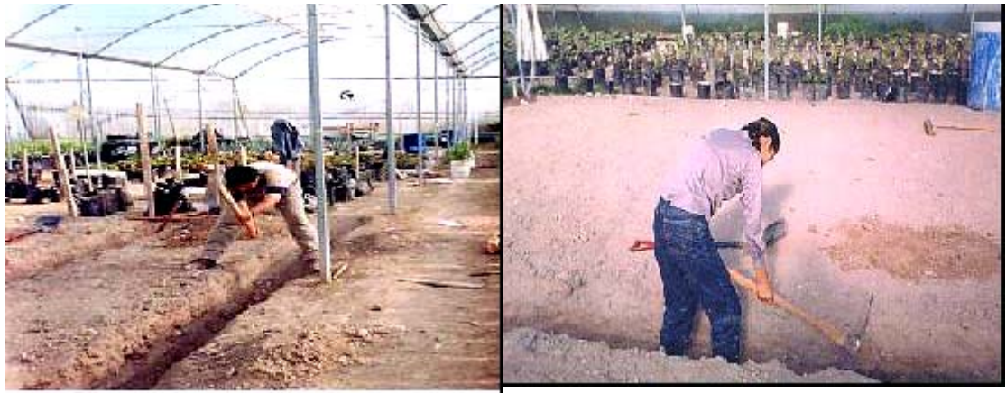
Figuras 3 y 4. Construcción de zanja para el establecimiento del cultivo en suelo
