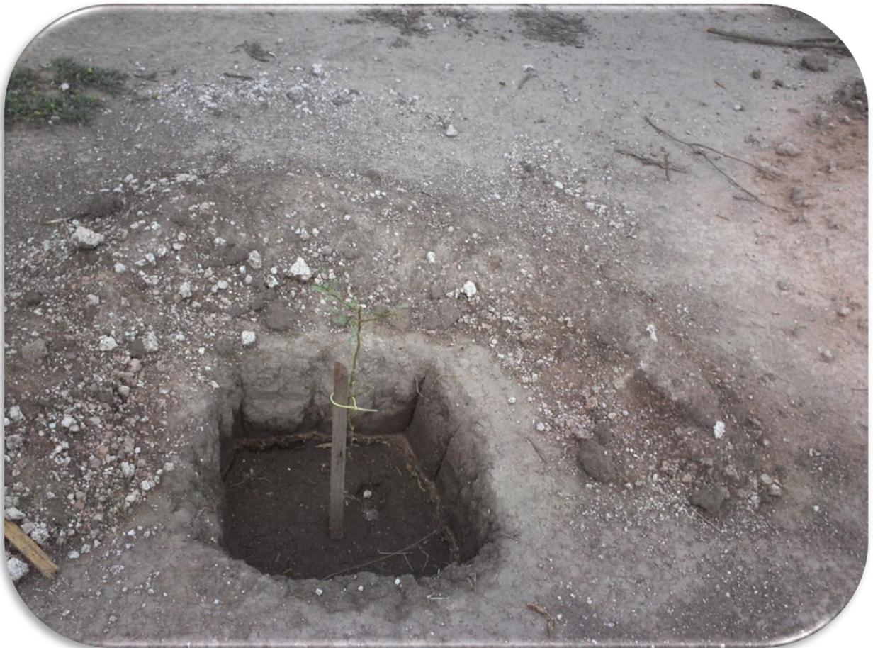
**Figura 12.** Cepa común correspondiente a la estructura 1 para la preparación del suelo y cosecha de agua.
