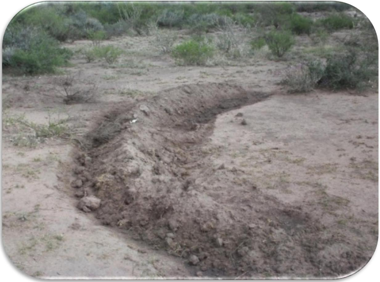
**Figura 15.** Bordos continuos en curvas a nivel correspondiente a la estructura 4 para la preparación del suelo y cosecha de agua.
