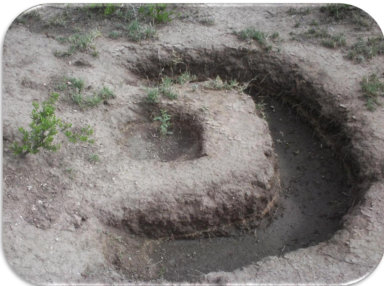
**Figura 13.** Zanja de 30 cm y bordo circular de 180° en cada planta correspondiente a la estructura 2 para la preparación del suelo y cosecha de agua.
