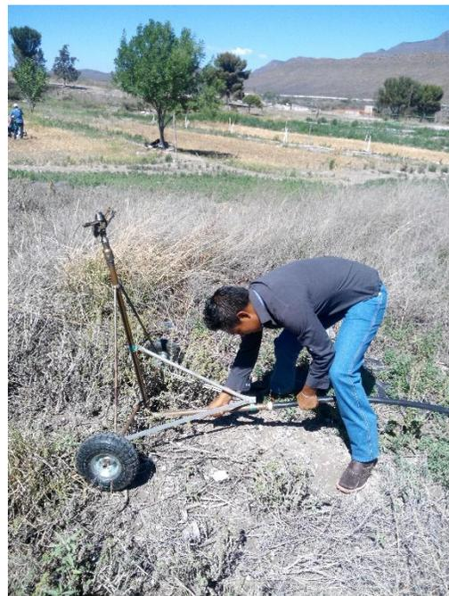
**Figura 14. Colocación de la manguera al carrito del cañón**
