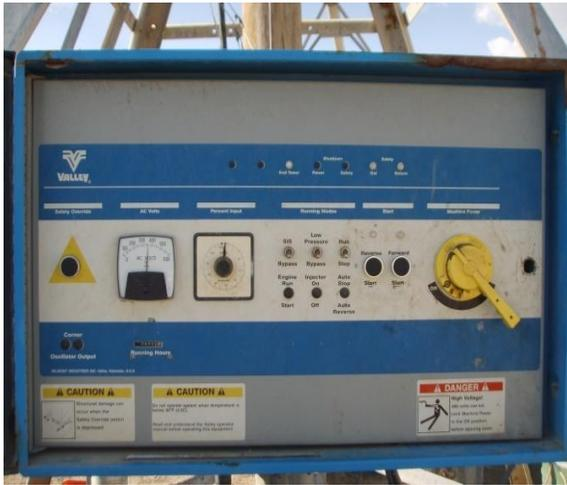
**Caja de control.** Para hacer llegar la corriente al centro del pivote es necesario tirar un cable hasta la ubicación de una caja con su transformador previamente instalada por la C F E de la cual se genera corriente 480 voltios que son con los que funciona el pivote central. Se instalan las varillas que activan los
