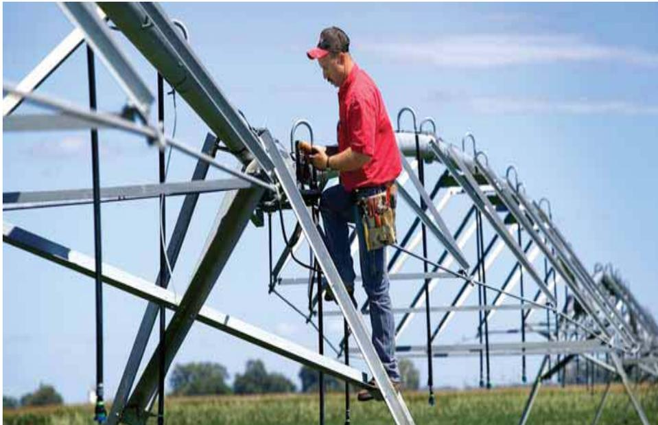
**INSTALACIÓN DE LAS CAJAS DEL SISTEMA ELÉCTRICO DE ESTE PIVOTE CENTRAL.**
