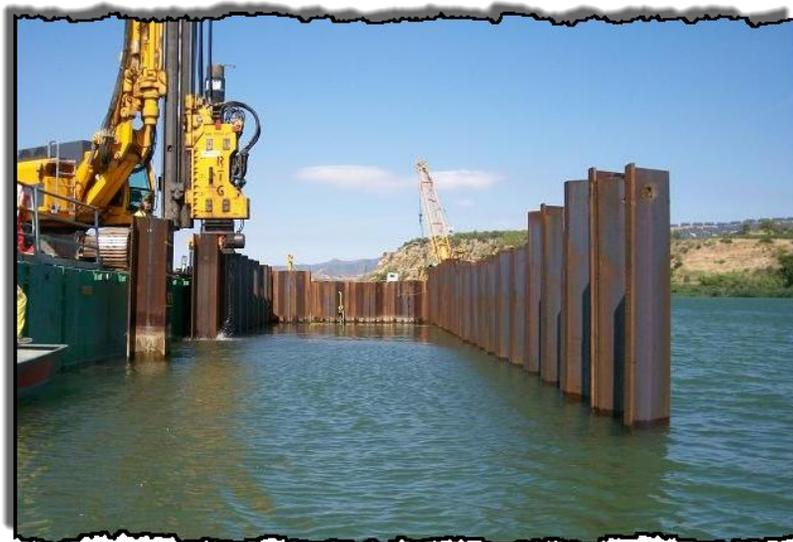
Figura 33. Hincado de tablaestacas para formación de ataguías.
