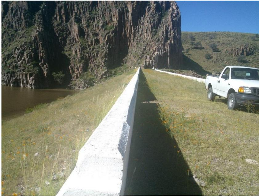
Figura 11. Murete construido en la margen derecha y aguas arriba de la corona
