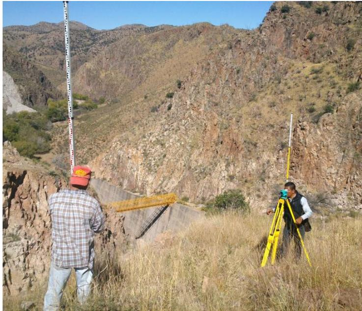
Figura 20. Nivelacion de la poligonal de apoyo de la Presa El Tintero, Namiquipa, Chihuahua.
