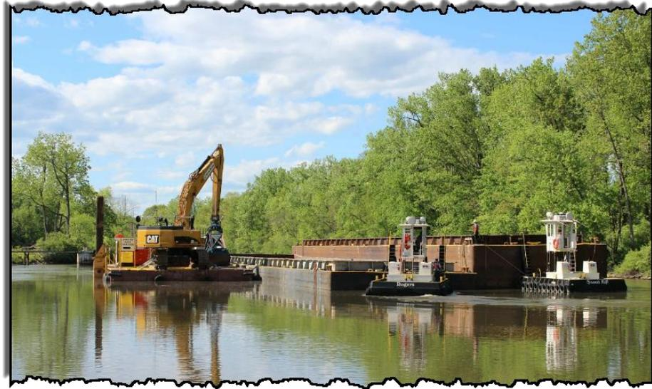
Figura 24. Dragado de un río utilizando barcas para la extracción del material de azolve.
