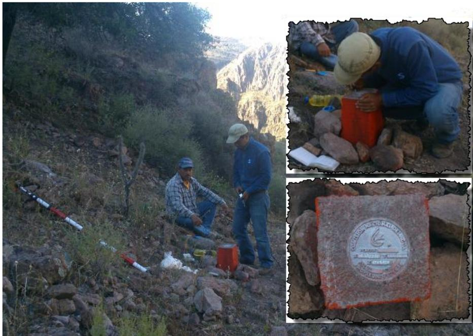
Figura 23. Monumento colocado sobre la margen izquierda de la cortina. Presa El Tintero, Namiquipa Chihuahua.
