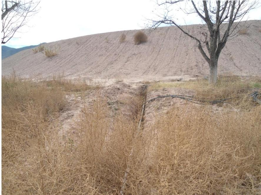
Figura 4.12 Excavación de la Zanja y tendido de la línea distribuidora
