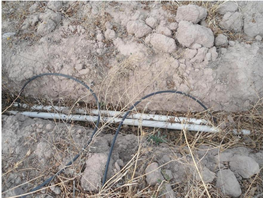
Figura 4.14 Conexión de iniciales y elevadores para conexión de mangueras de goteo.
