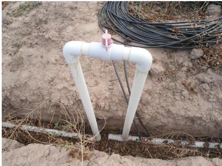
Figura 4.13 Válvula de seccionamiento para el riego de cada bloque.
