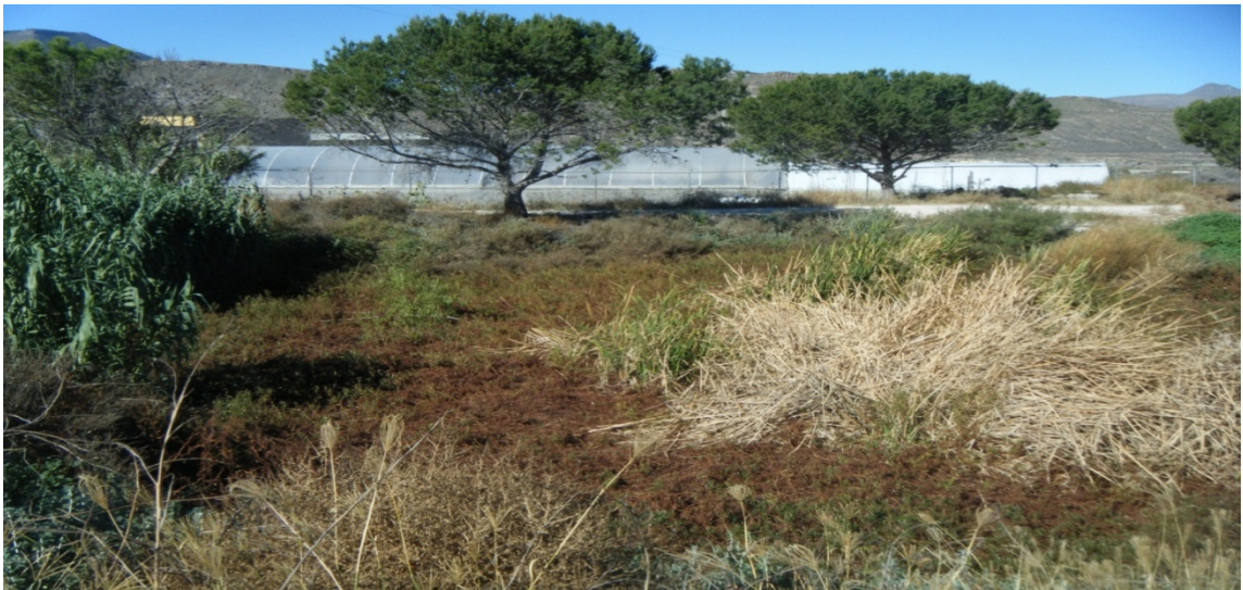
Figura 5. Estanque de Sedimentación.
