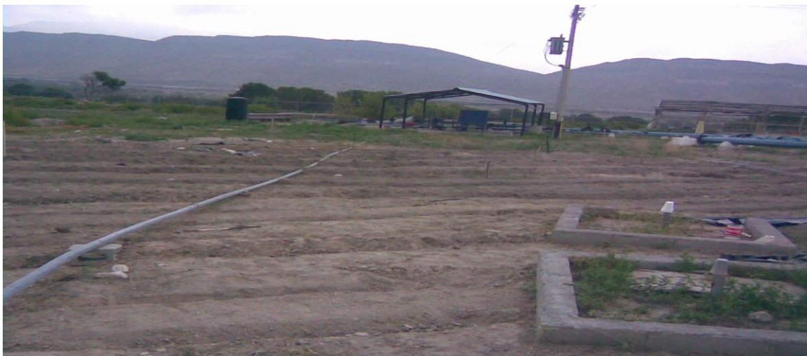
Figura 3.6. Construcción de camellones manualmente.
