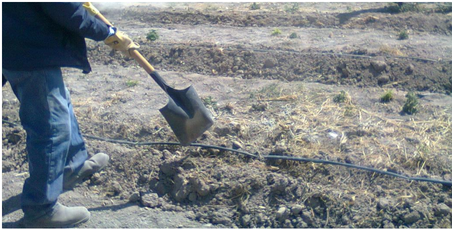
Figura 3.7. Instalación de mangueras regantes después de incorporar la composta.
