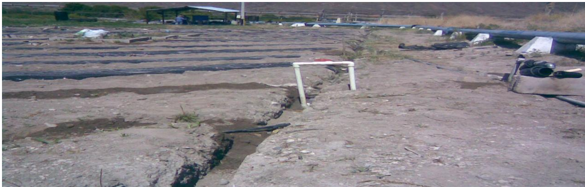
Figura 3.4. De instalación un columpio Pvc con una válvula globo de las líneas de distribución.
