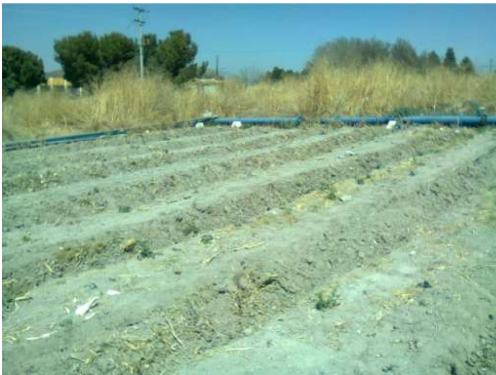
Figura 3.3 construcción de camellones manualmente
