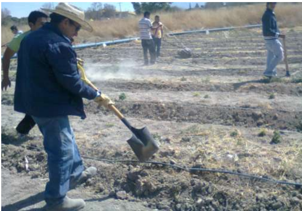
Figura 3.4 instalación de cintillas (aqua-traxx)
