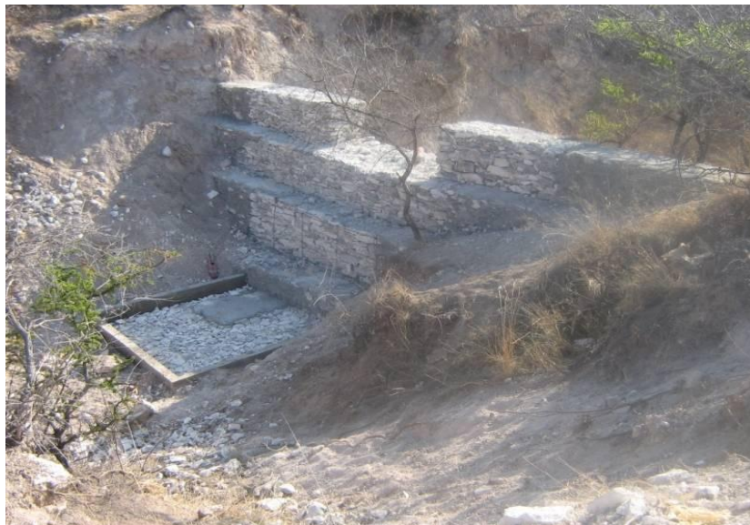
Figura 7. Presa filtrante de gaviones (CONAZA, 2010).
