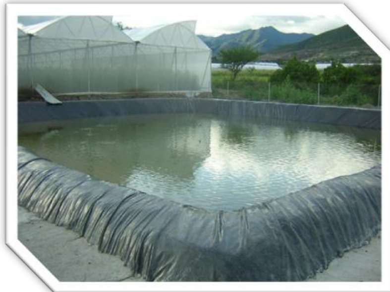
Figura 5.7. Olla de agua recubierta con geomenbrana (CONAZA, 2010).
