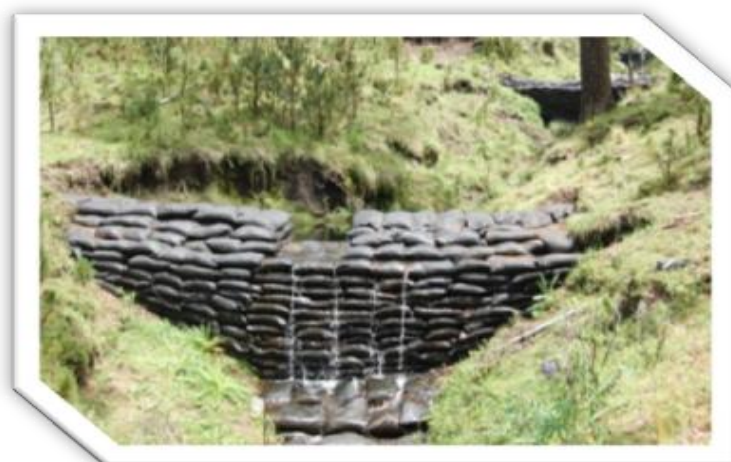
Figura 5.6. Presa filtrante de geocostales (CONAZA, 2010).
