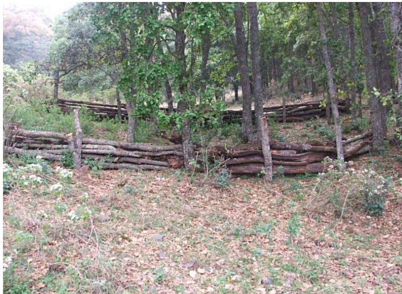
Figura 9. Presas filtrantes de troncos o ramas (CONAZA, 2010).
