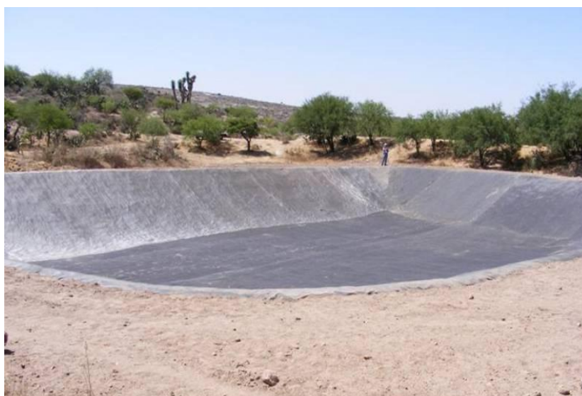
Figura 15. Recubrimiento con geomembrana (CONAZA, 2010).
