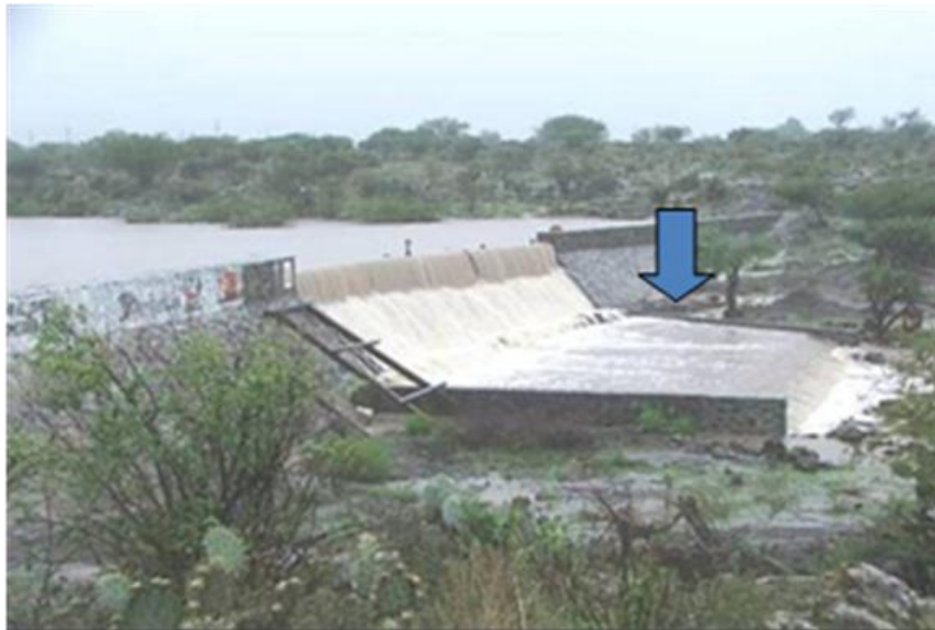
Figura 11. Colchón hidráulico, Delantal (CONAZA, 2010).
