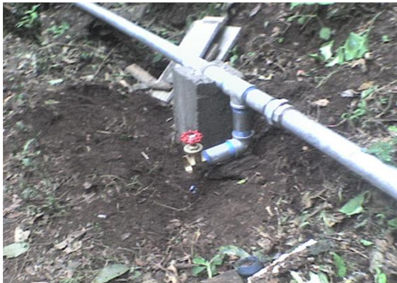
Figura 13. Instalación de línea de conducción (CONAZA, 2010).
