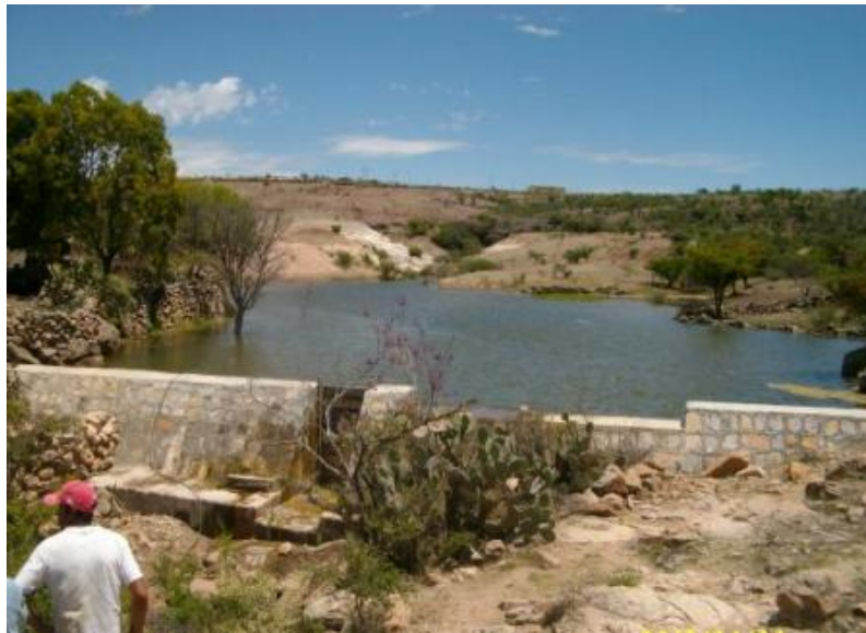
Figura 2. Pequeña presa, Represa (CONAZA, 2010).
