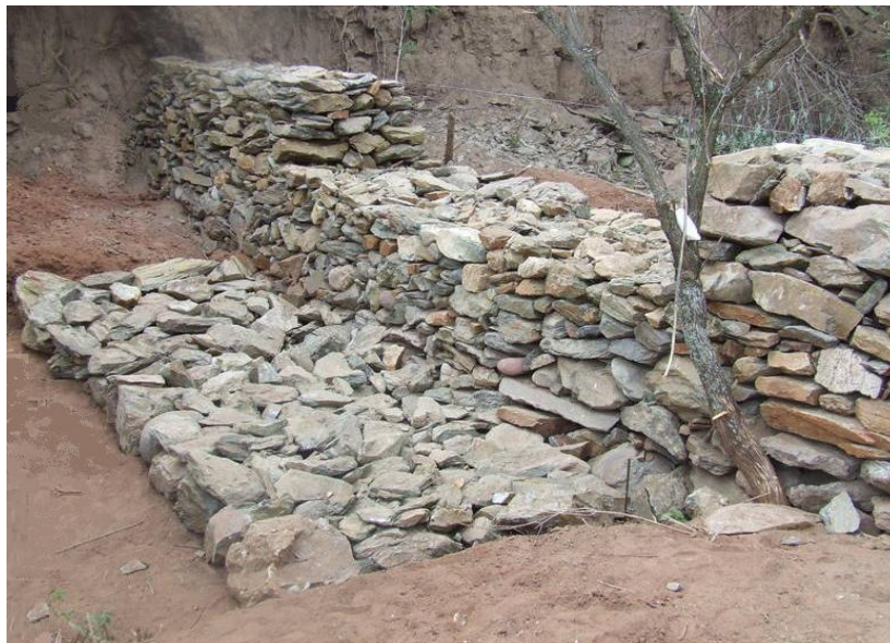
Figura 8. Presa filtrante de piedra acomodada (CONAZA, 2010).
