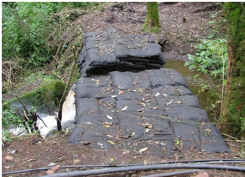
Figura 6. Presa Filtrante de costales rellenos de tierra (CONAZA, 2010).
