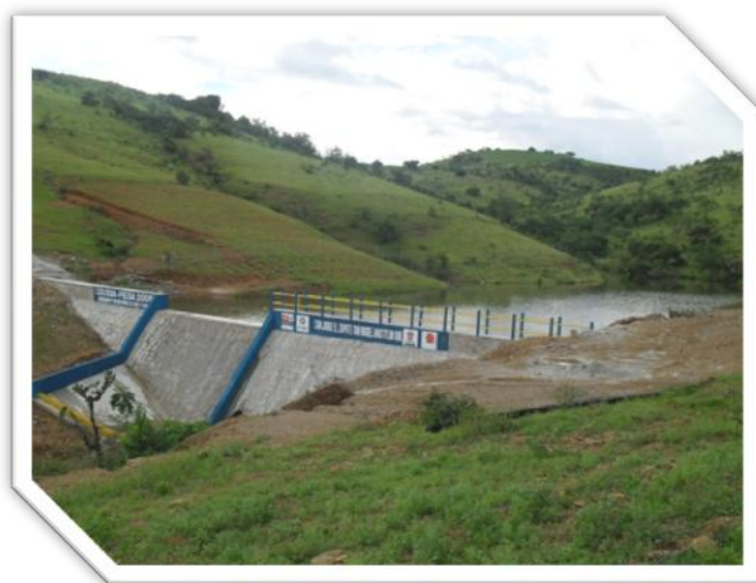
Figura 5.2. Pequeña presa de mampostería (CONAZA, 2010).
