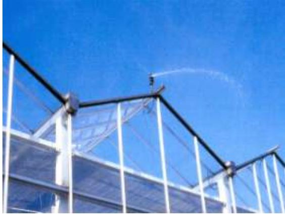
Figura 2.4.-Riego de la cubierta
