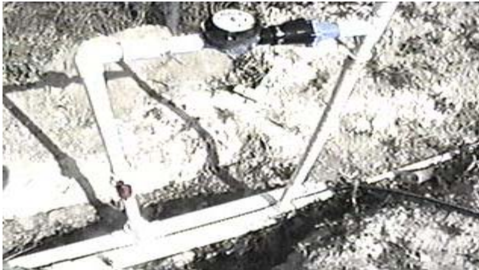
Figura 2: Puente de toma de agua, medidor de agua, regulador de presión e instalación de manómetro
