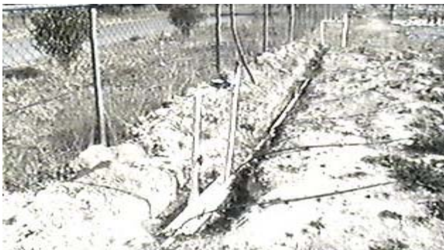
Figura 3: Conexiones de la línea secundaria a las líneas regantes de cada cama de los cultivos.
