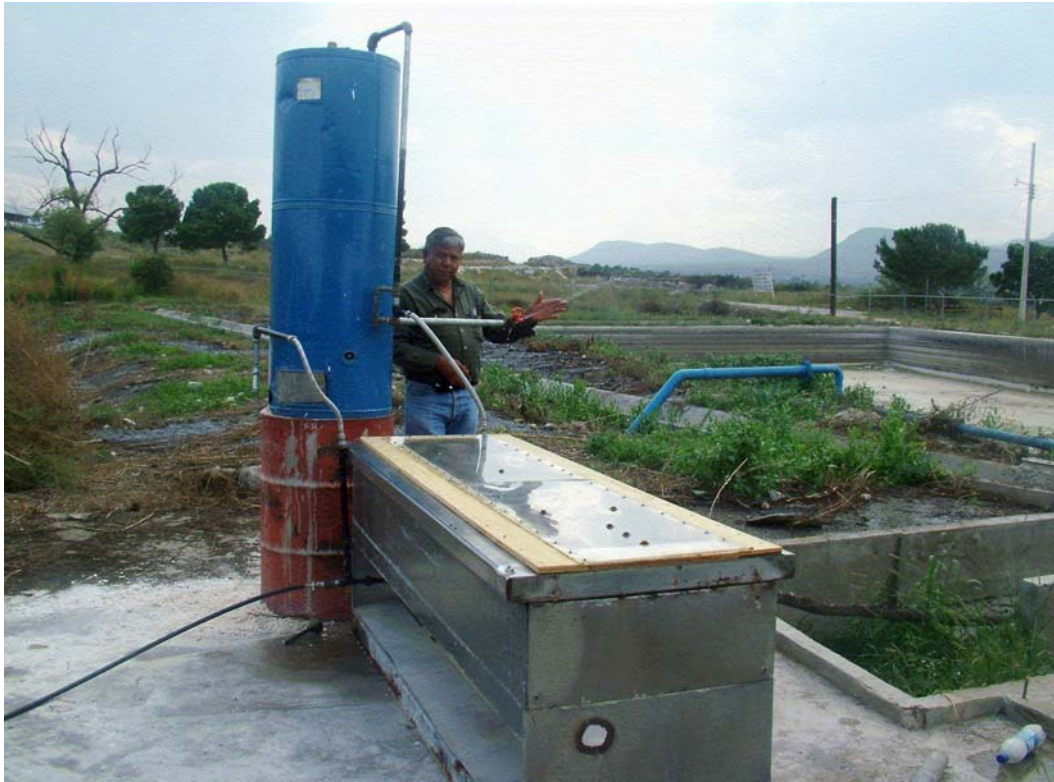
Figura 3.1 Instalación del experimental del calentador solar.
