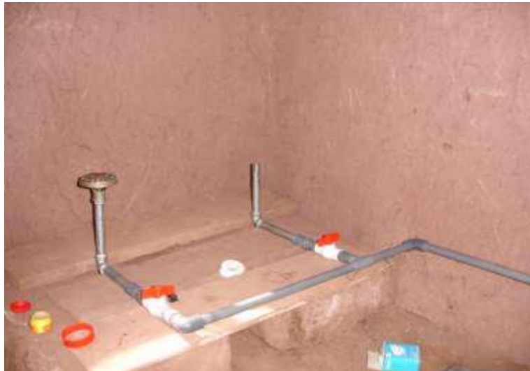
FIGURA 10. QUEMADOR EN LA COCINA
