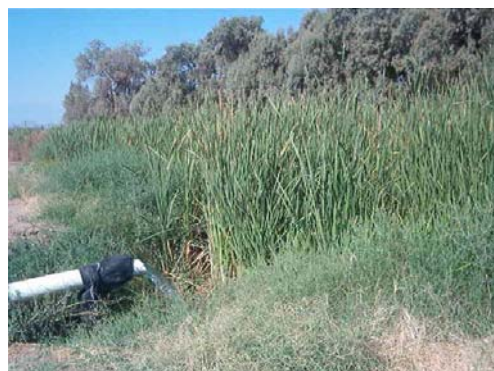
Estanque sin revestir para agua, con descarga del pozo profundo
