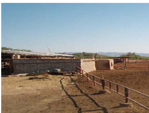
Construcción de Bodega y Oficina – almacén
