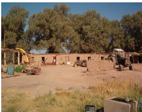
Construcción de cuartos para taller
