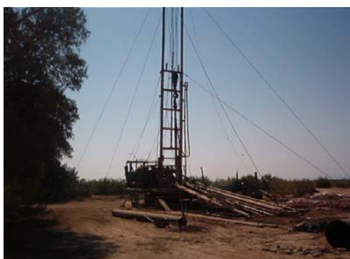
Perforación de pozo profundo para reposición de pozo anexo al establo
