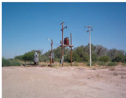
Pozo profundo de uso agrícola con transformador, motor y bomba verticales.
