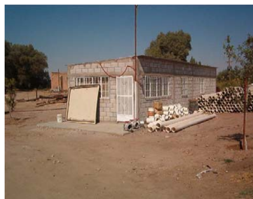
Construcción de Oficina del Propietario
