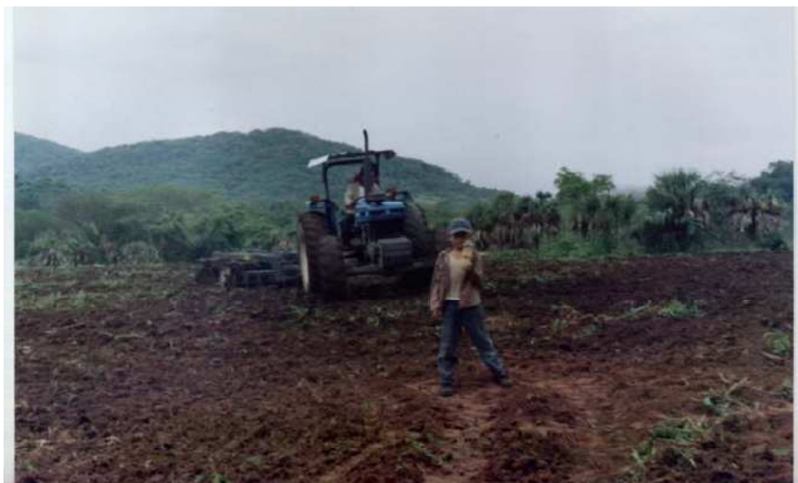
Imagen 4. Preparación del terreno
