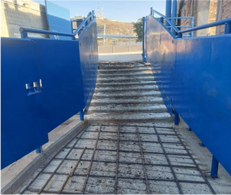
Figura 1 Piso especial anti de rapante en área de desembarque para bovinos.
