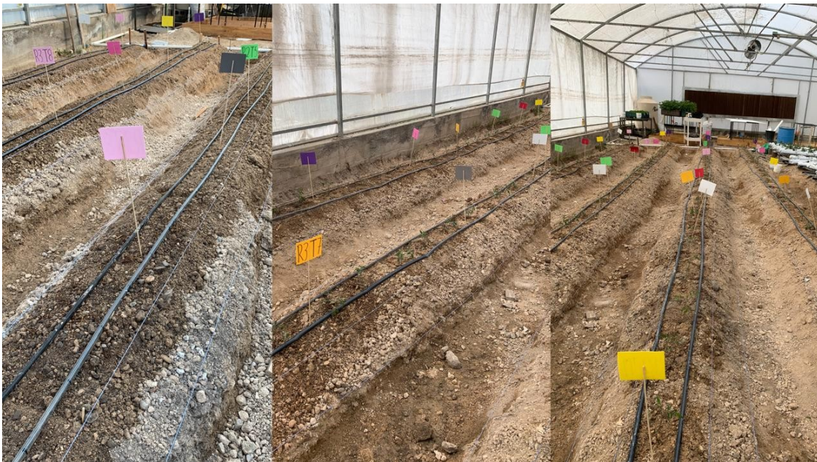
Fotografía 2. Preparación de camas de cultivo y sistema de riego por goteo dentro del invernadero antes del trasplante.
