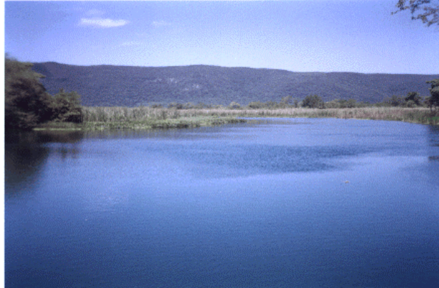
Foto 1.- Presa La Aguja.
