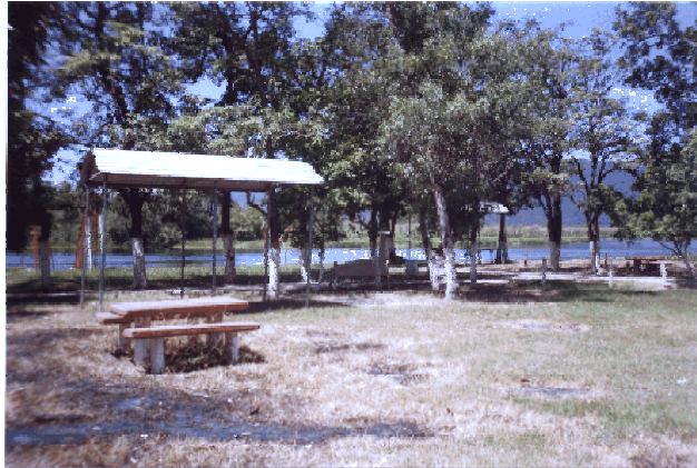
Foto 2.- Instalaciones de la presa.
