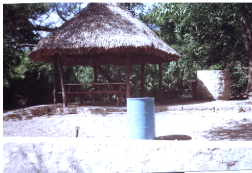
Foto 22.- Instalaciones de La Florida.
