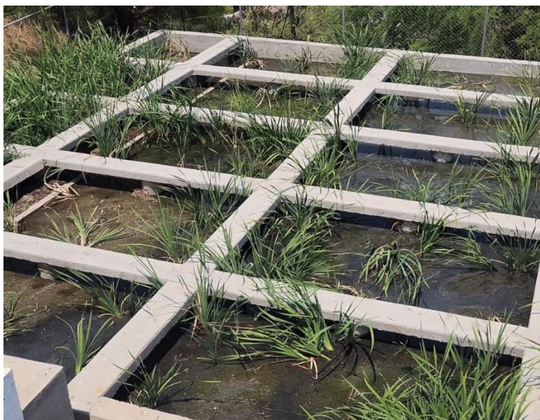
Figura 9. Sitio de muestreo "Humedal Artificial" en la PTAR-La Estancia
