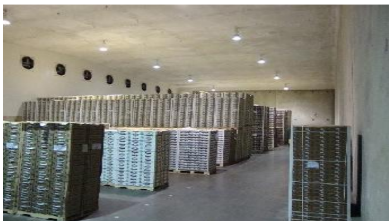
Figura 13. Sistema de almacenamiento en frío
