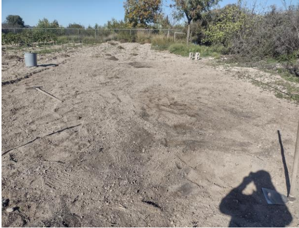
Preparación de terreno
