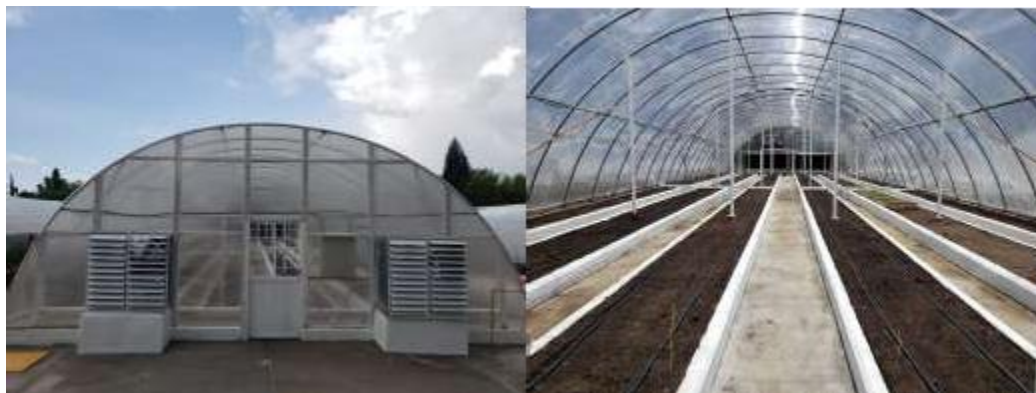
Figura 12. Fachada e interior del invernadero No. 5 (UAAAN).
