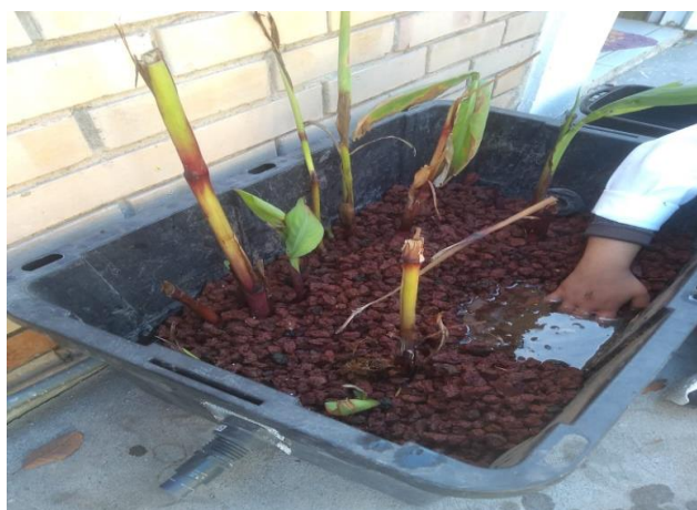
Figura 3. Construcción de humedal artificial.
