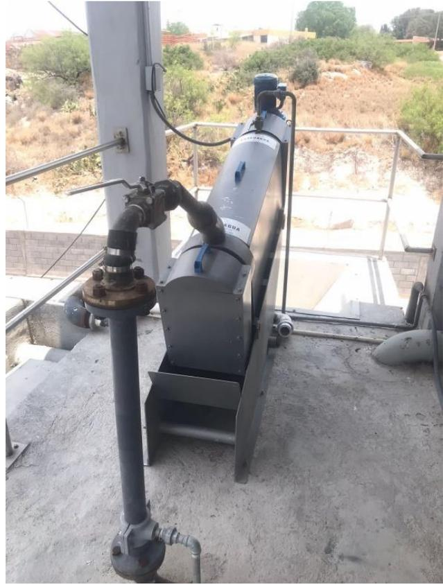
Figura 3. Tornillo Prensa (PTAR-UAAAN, 2022).
