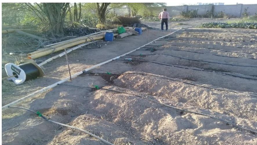
FIGURA 6. Instalación del sistema de riego
