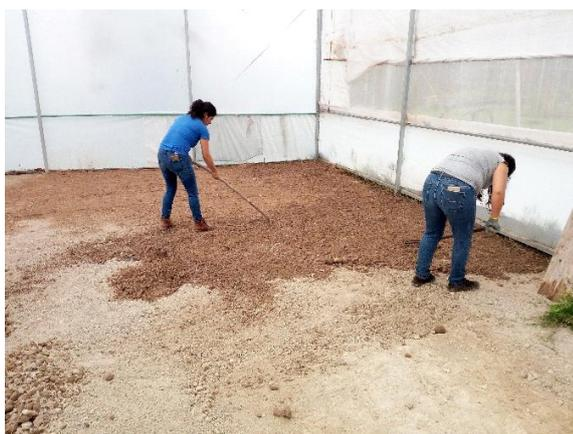
*Imagen 5. Nivelación y preparación del terreno.*
