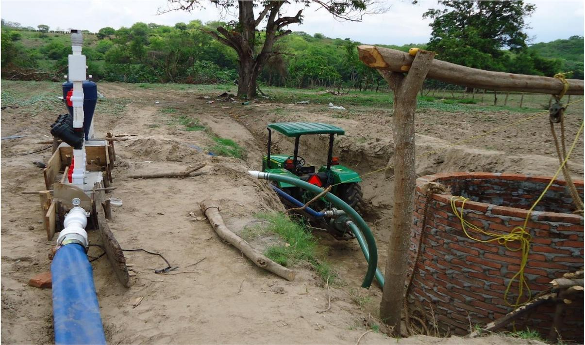
**Figura 9.** Cabezal de control del sistema de riego.
