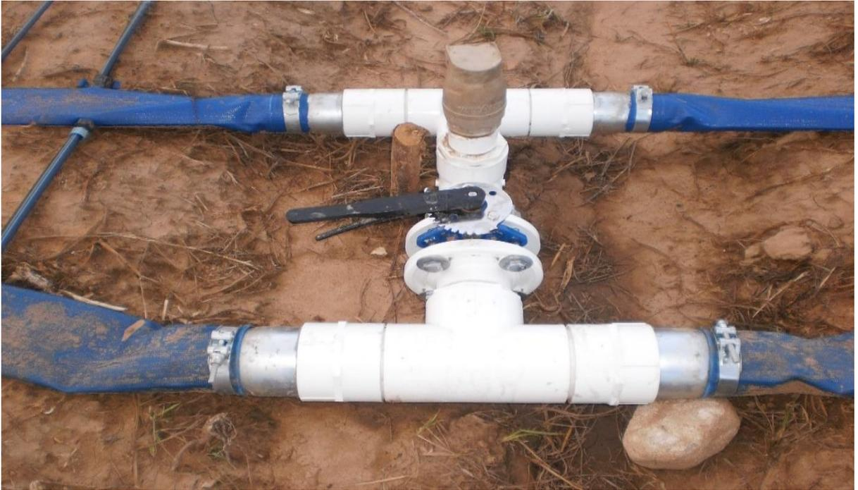
**Figura 7.** Válvula de seccionamiento tipo mariposa.
