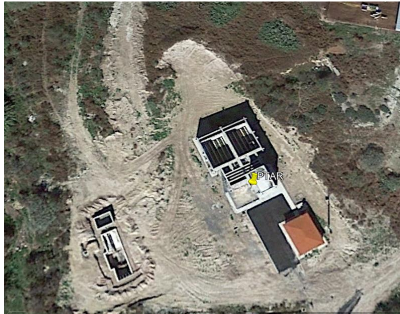
Figura 3. Ubicación geográfica de la PTAR-UAAAN (Google Earth 2016)
