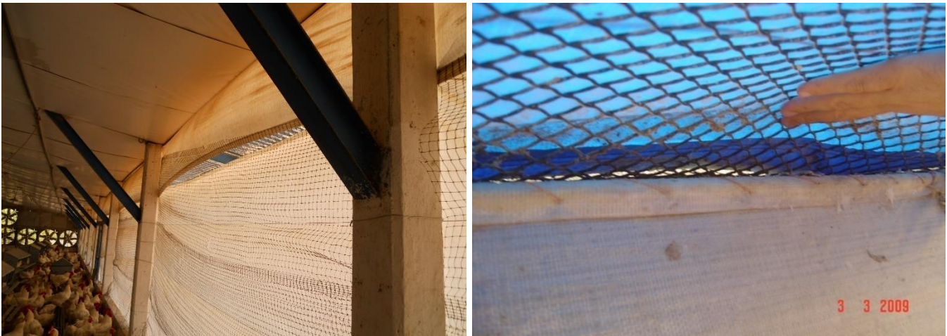
Figura 24 y 25: Entradas falsas de aire en la caseta “sellada”(comarca lagunera)
