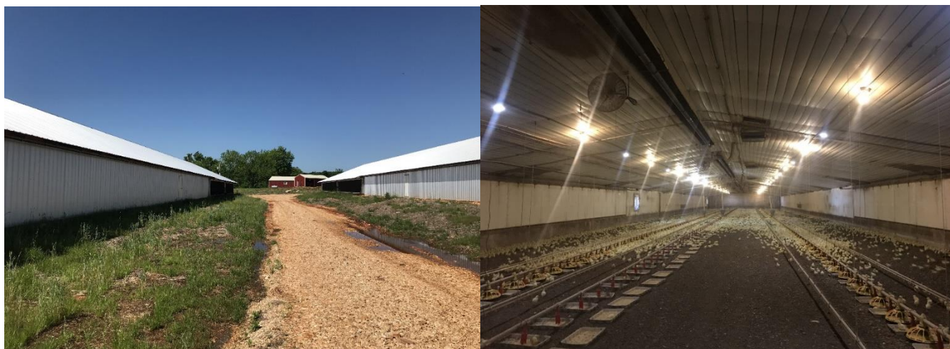
Figura 4 y 5: Ventilación tipo túnel (Granjas Springfield MO)
