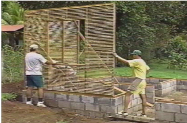
©Ibíd., colocación de paneles
