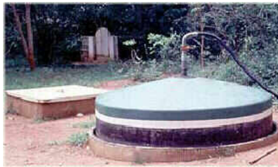
Figura 8. Digestor tipo hindú.
