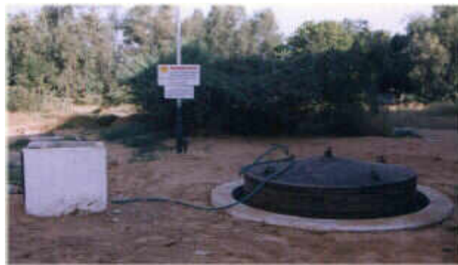
Figura No. 9. Ejemplo de digester hindú.
