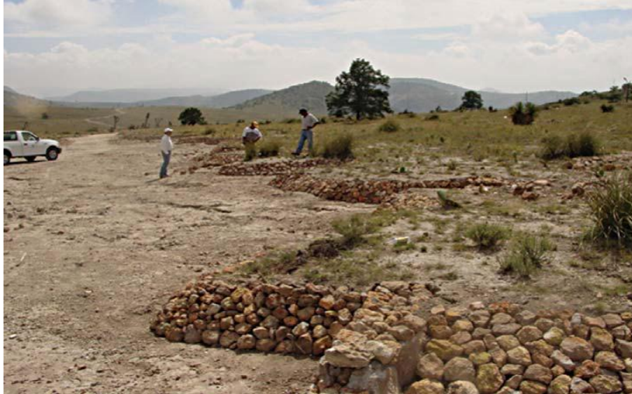
FiguraII.2.- Estabilización de taludes
