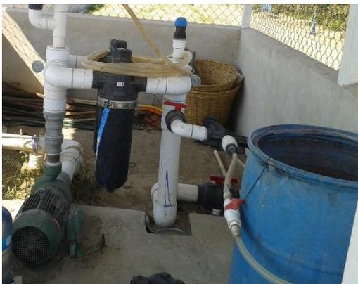
Figura 3.10. Cabezal de riego huerta 2
