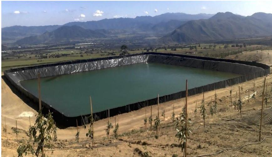
**Figura 2.12.** Reservorio con geomembrana.
