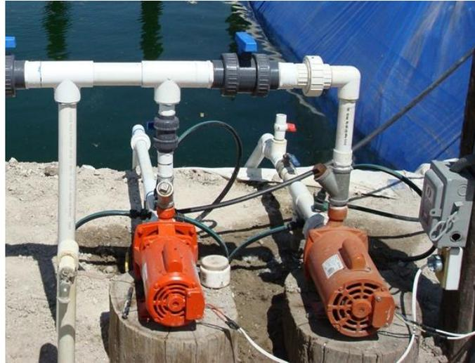
**Figura 2.13.** Conjunto de bombas centrífugas instaladas en paralelo.
