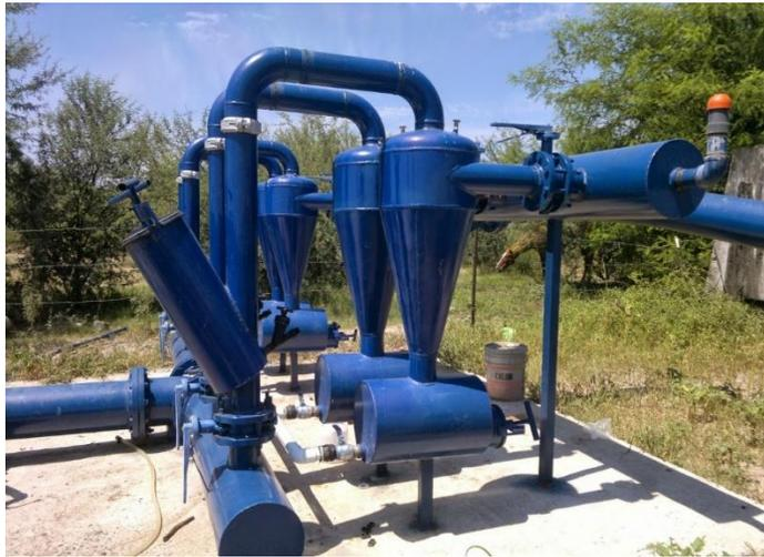
**Figura 2.14.** Conjunto de hidrociclones a la salida de un pozo
