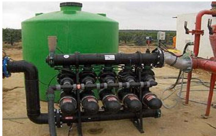
**Figura 2.19.** Bateria de filtros de anillas en un cabezal de riego.
