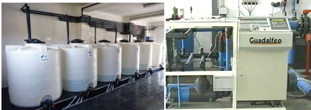
Figura 12. Tanque de solución de fertilizantes (izquierda) y Programador de riego (derecha)
