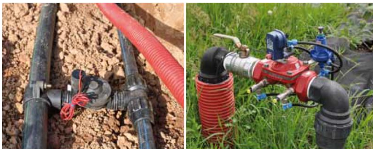
Figura 13. Diferentes tipos de electroválvulas
