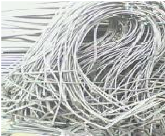
Estacas y tubin
